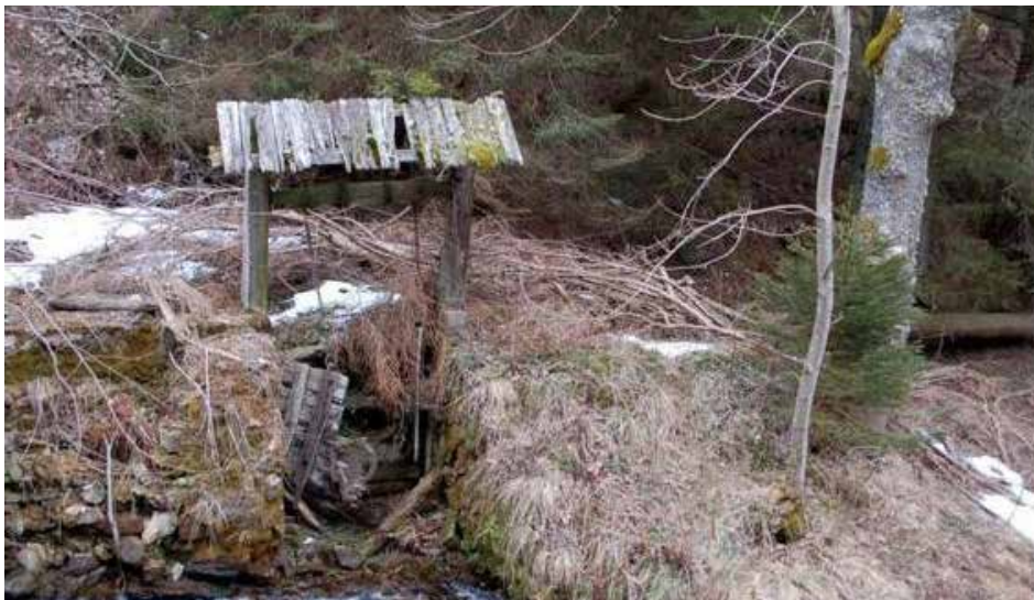
Zapornica za vodo za polnjenje tlačnih cevi za Rakovško žago
