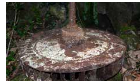
Turbina Župančeve elektrarne in mlina
