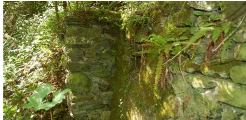
Zidovje Župančevega mlina
